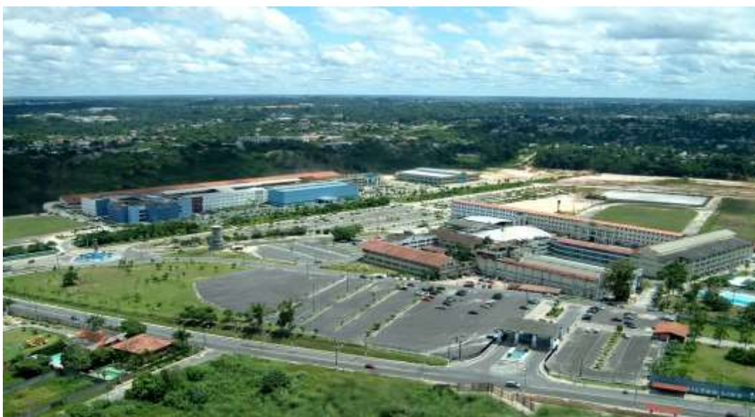
Vista área do Campus da Universidade Nilton Lins / Parque das Laranjeiras / Manaus – AM
